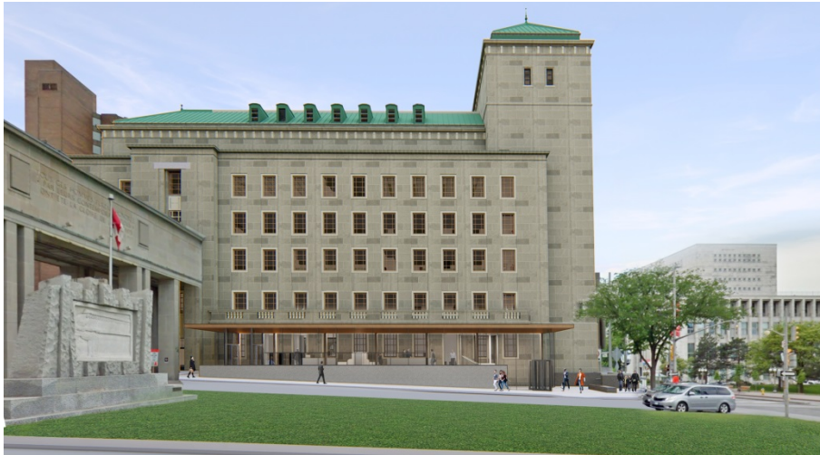
Vue de la rue Lyon
