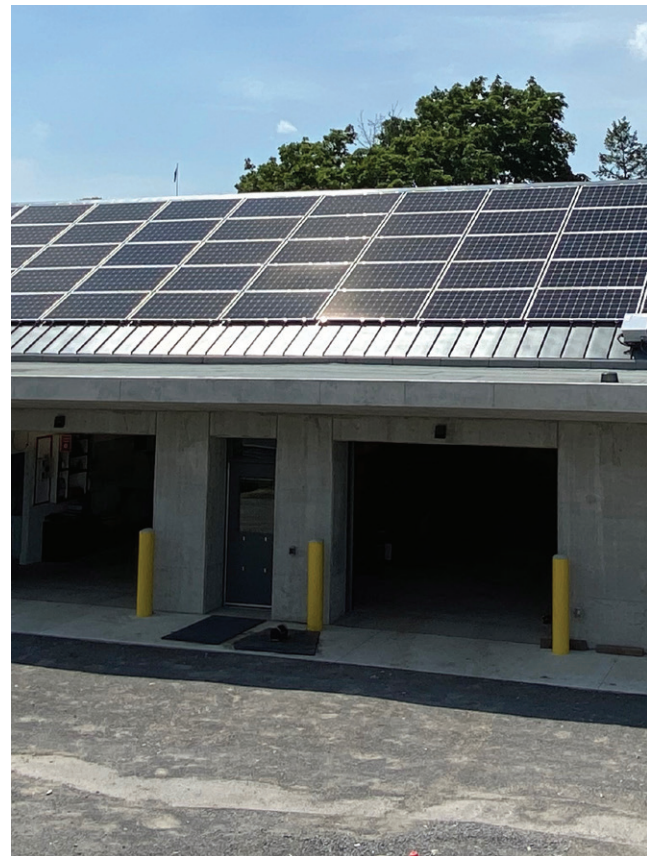
« La Grange », une nouvelle construction carboneutre à Rideau Hall
