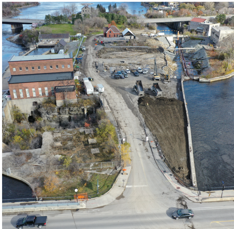
Travaux de décontamination à l'île Victoria
