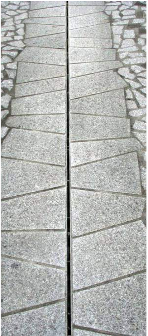
Fig. 142 Drain d'écoulement dans le pavé Source: www.landezine.com/st-flour-pavement-by-insitu-landscape-architecture-01.jpg
