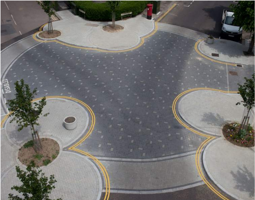
Fig. 31 Intersection surélevée avec traitement graphique Source: www.volkerwessels.co.uk/en/projects/detail/diy-streets-turnpike-lane-area-part-of-haringey-htm
