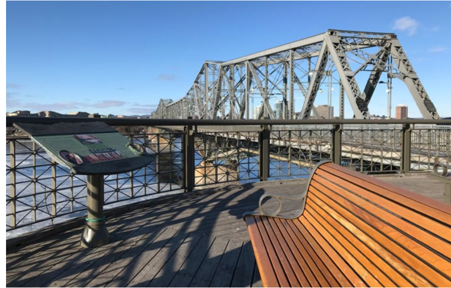
Panneaux d'interprétation sur le pont Alexandra. Source: Alexandra Bridge Replacement Program and Design Guidelines (CCN)
