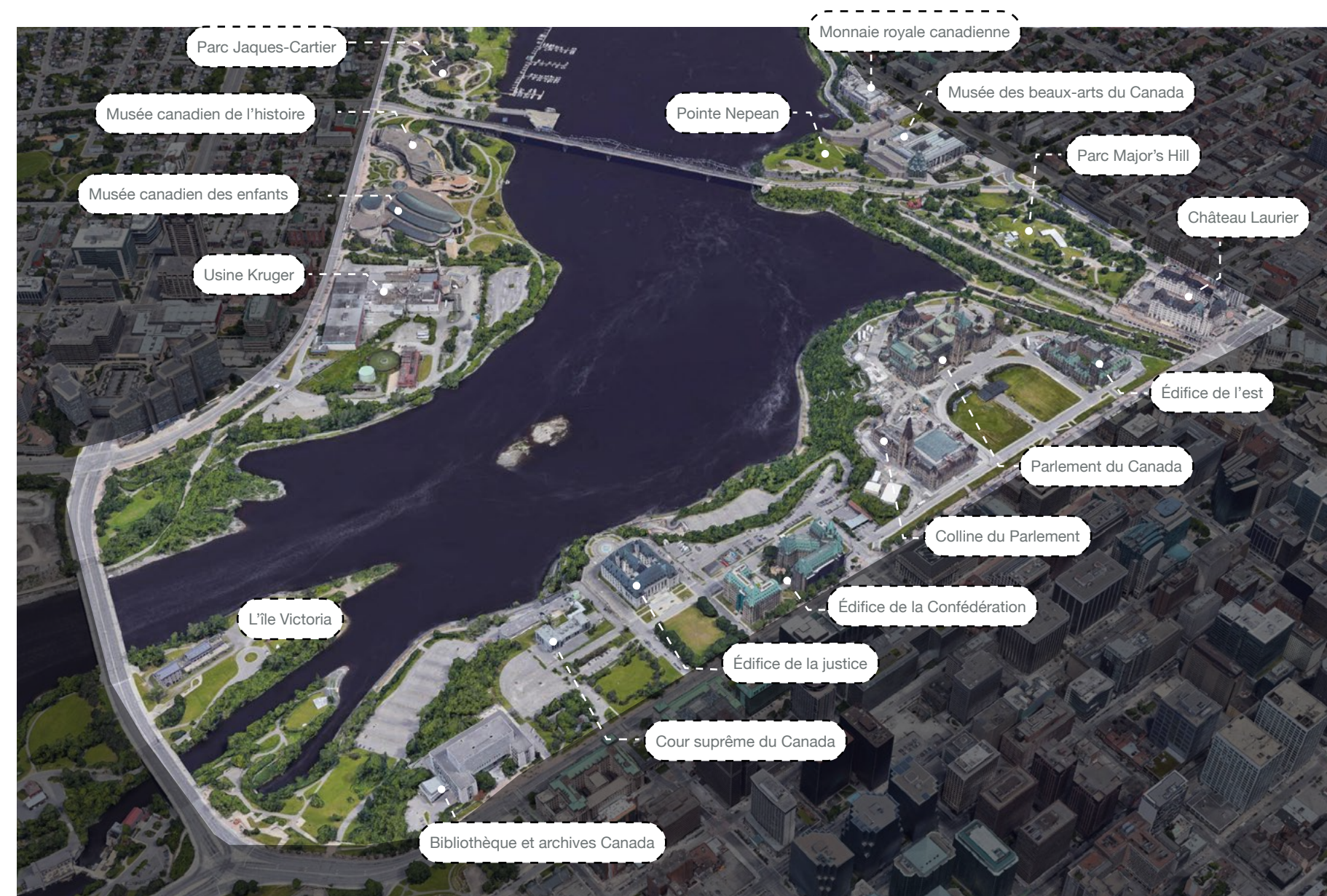
Vue aérienne du Boulevard de la Confédération. Source: Image de Google Earth
