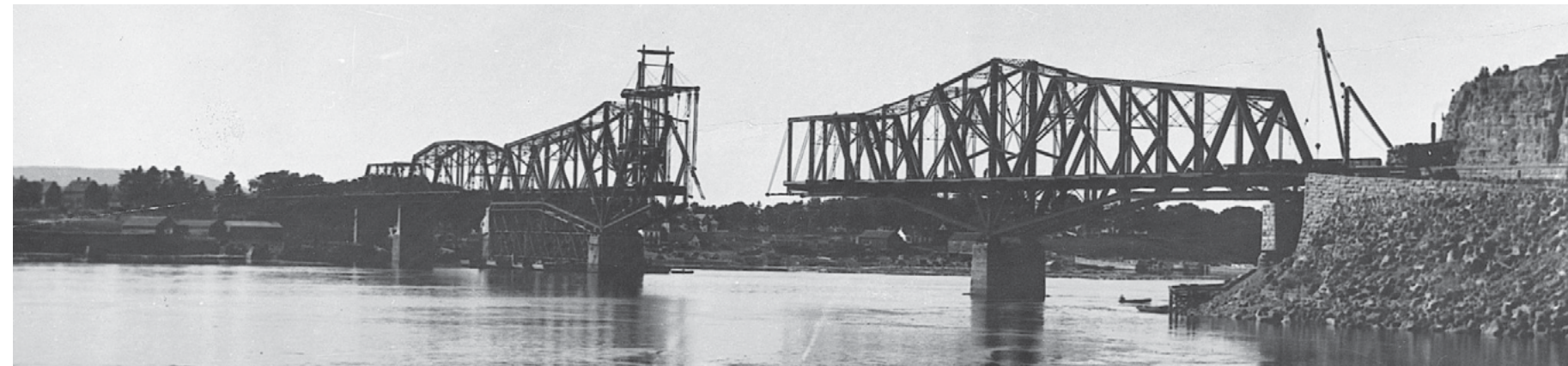
Le point interprovinciale (maintenant le pont Alexandra) pendant sa construction, 1901. Source: LAC/Topley/PA-013866
