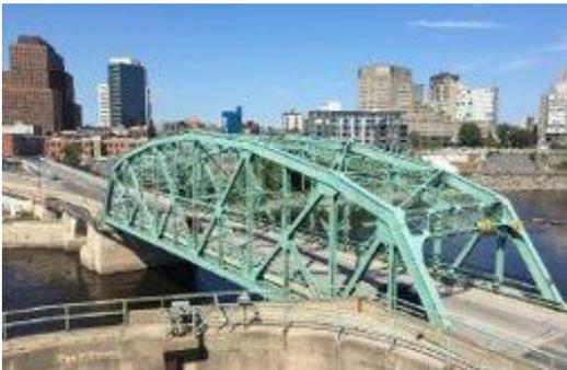
La cote actuelle de l'état structural est de 3 (médiocre). La cote est principalement déterminée par la détérioration avancée des longerons, des pièces de pont et des montants du treillis situés dans la zone d'éclaboussement. Le tablier en béton a été construit sans membrane d'étanchéité ni couche d'usure sacrificielle, et il présente des défauts indiquant un état de détérioration avancé. Les murs garde-ballast sont gravement détériorés, ce qui crée un risque important de défaillance.
