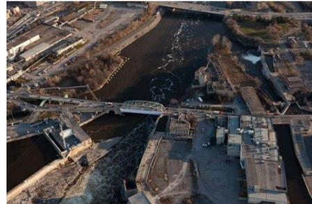
La cote actuelle de l'état structural est de 4 (acceptable). Cette cote découle principalement des travaux mineurs requis sur les composants principaux. Après la fermeture du pont sur chevalets de Hull, qui était auparavant utilisé pour la circulation en direction sud, le pont-jetée de Hull a été transformé en voie de circulation à deux voies. Cette transformation a soulevé des préoccupations quant à la sécurité pour les cyclistes.
