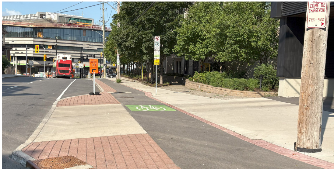
Figure 47 : Trottoir et piste cyclable continus qui traversent une entrée charretière, avec une rampe dont la largeur se limite à celle de la banquette et rayon de virage réduit au minimum
