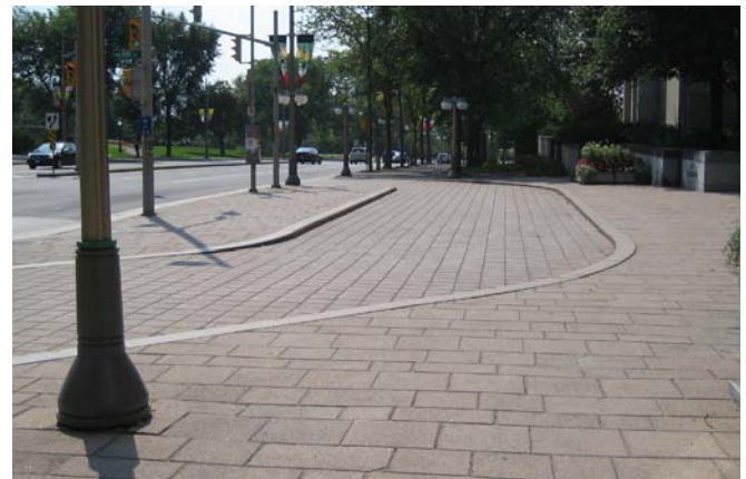
Chaussée en béton sur la rue Wellington
