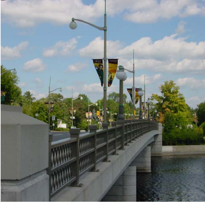
Pont Bytown sur la promenade Sussex
