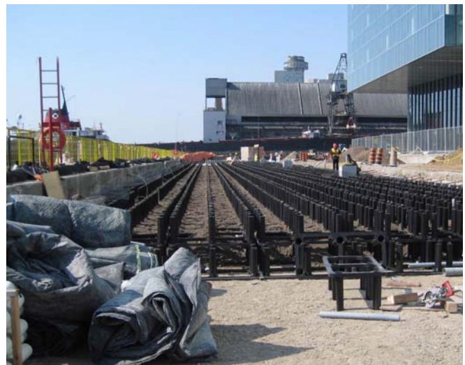
Cellules de sol installées dans le secteur riverain de Toronto
