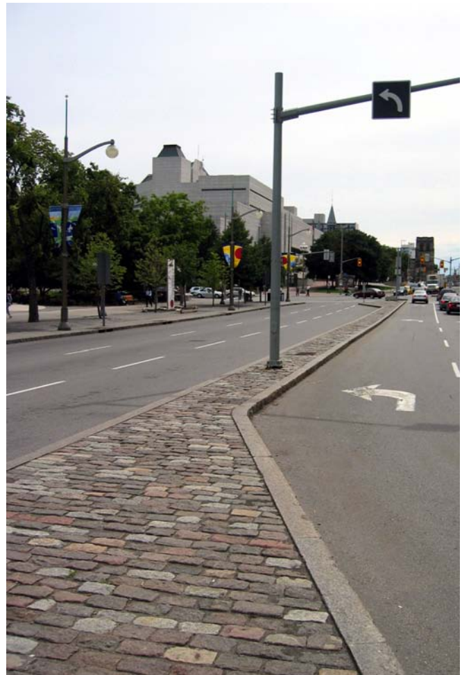
Rue Elgin : pavés de granite dans le terre-plein central
