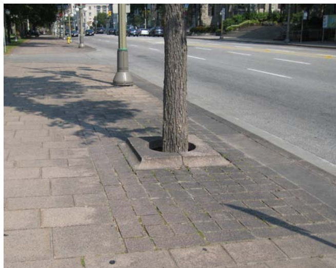
Pavé de granite et protecteur en béton précoulé sur la rue Wellington
