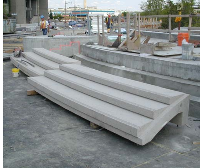
Escalier de béton précoulé lors de l'installation
