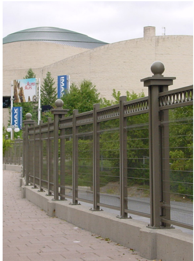
Clôture métallique : rue Laurier
