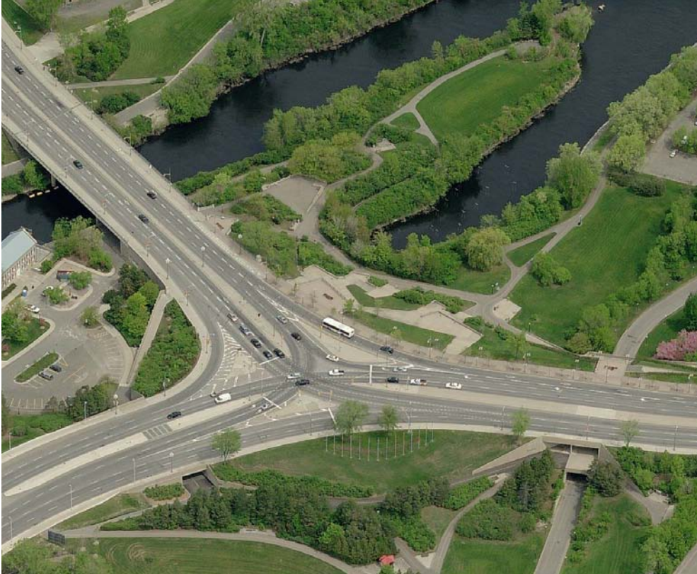
Carrefour Wellington/Portage Vue du sud-est
