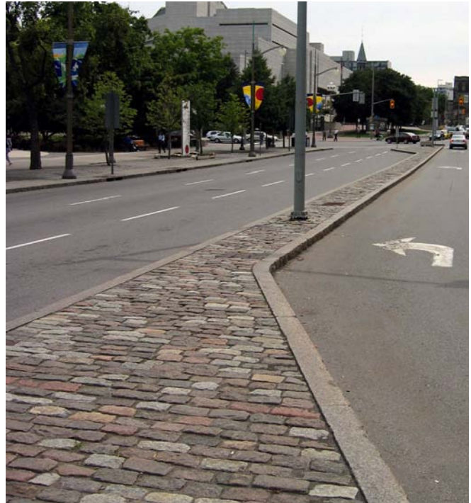
Pavés de granite dans le terre-plein central de la rue Elgin
