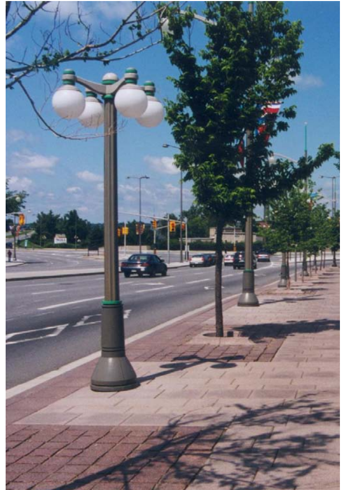
Bordures de chaussée en granite le long de l'esplanade
