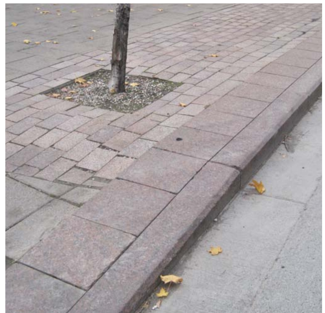
Bordures de chaussée en granite sur l'avenue Mackenzie
