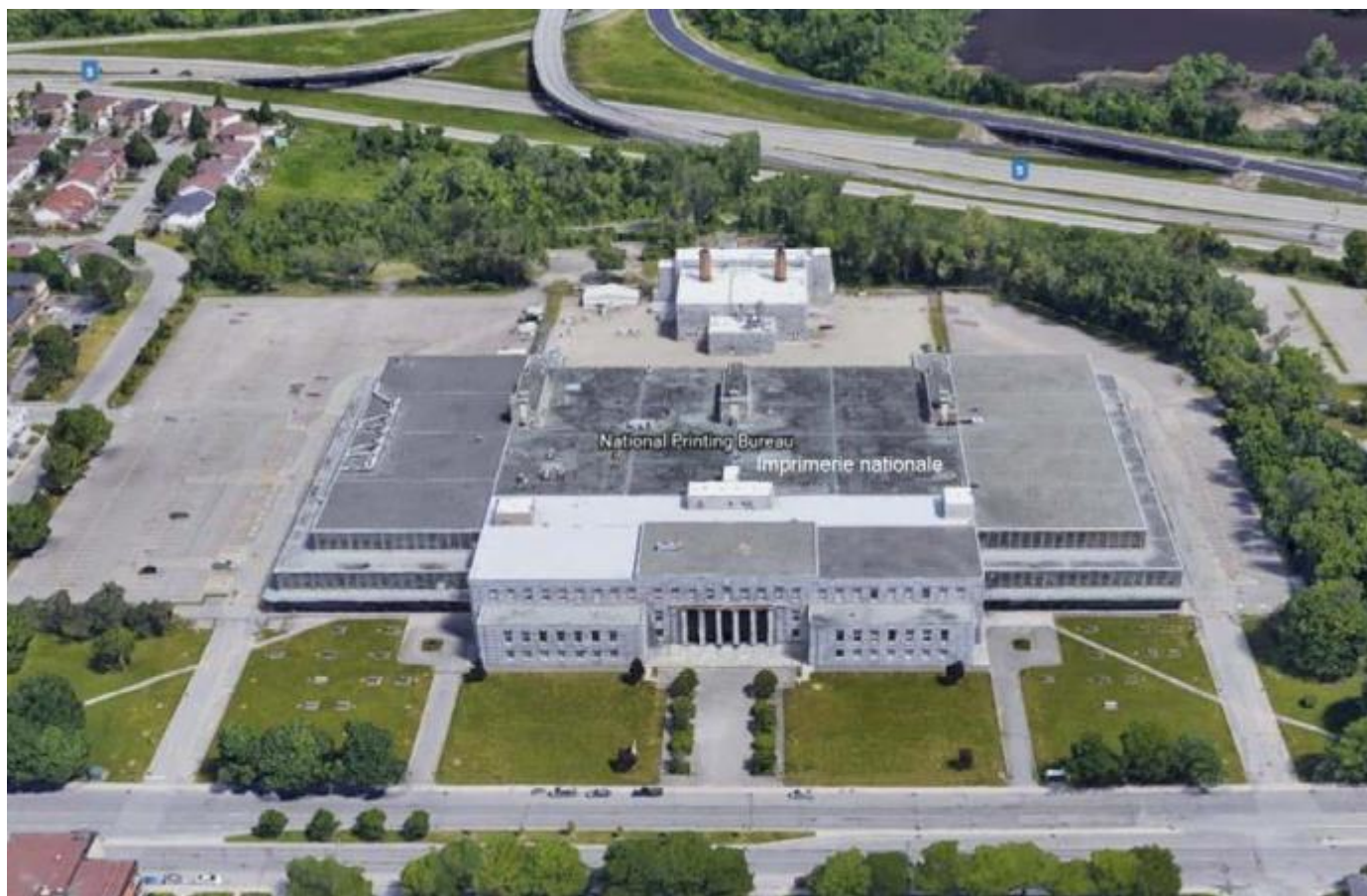
Aerial view of existing National Printing Bureau | Vue aérienne actuelle de l'imprimerie nationale
