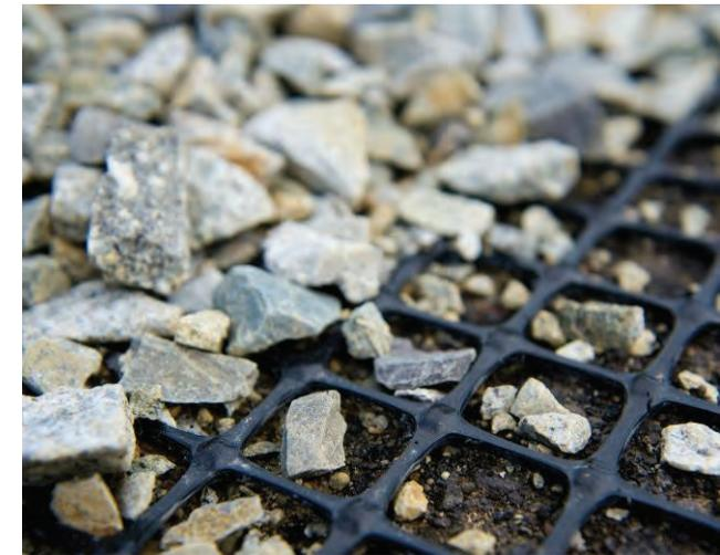
Exemple d'utilisation d'une géo-rigle renforcée dans la fondation d'un sentier.
