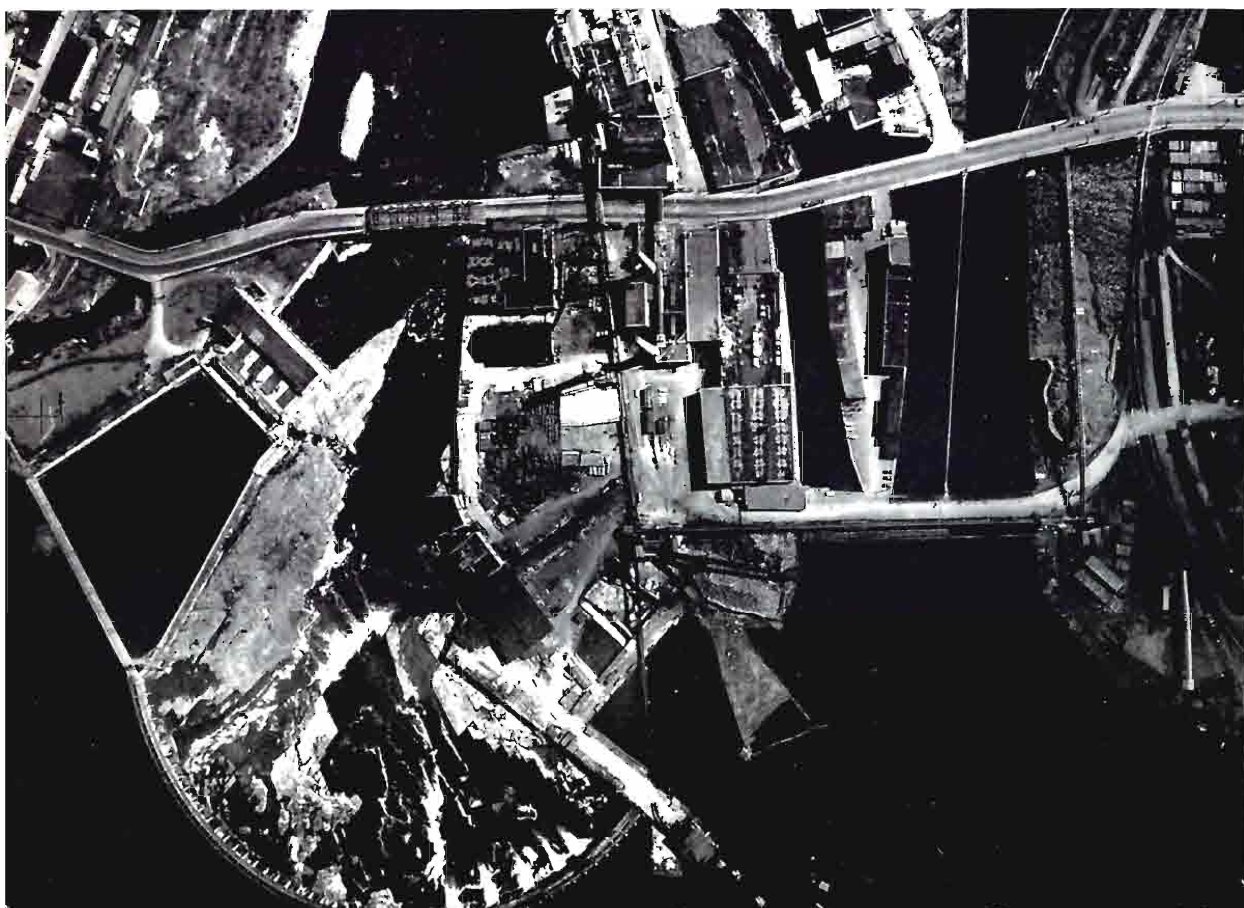
VUE AÉRIENNE DES ÎLES DE LA CHAUDIÈRE ENCOMBRÉES D'USINES
