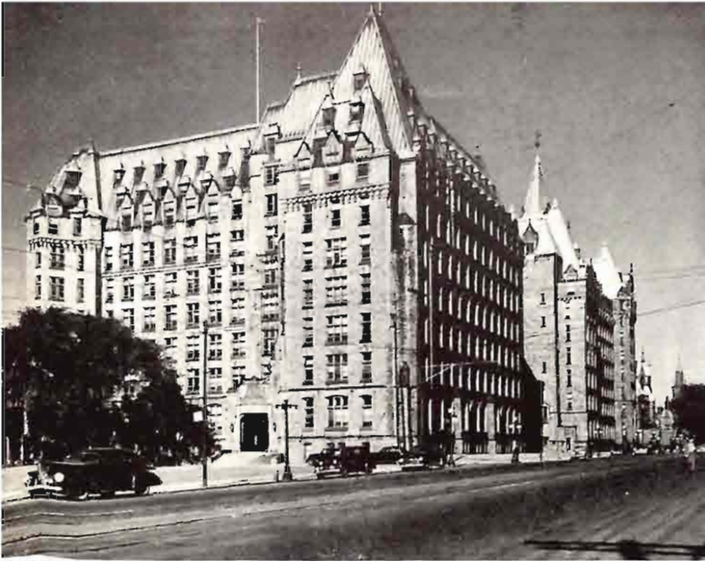
63 LES ÉDIFICES DE LA JUSTICE ET DE LA CONFÉDÉRATION montrent une préoccupation de formes désuètes et volontairement tourmentées. De plus, les constructions sont fâcheusement alignées contre la rue et appellent une trop grande concentration d'employés.
