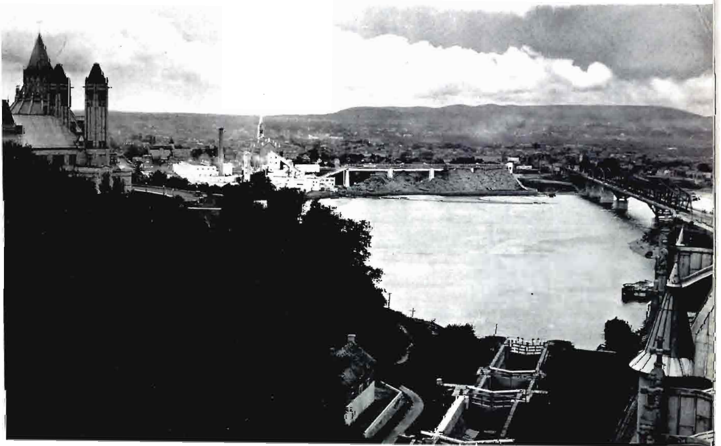
VUE PANORAMIQUE PRISE DU CHATEAU LAURIER
