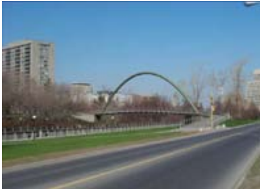
Figure 139. – Passerelle à arc simple surélevée.
