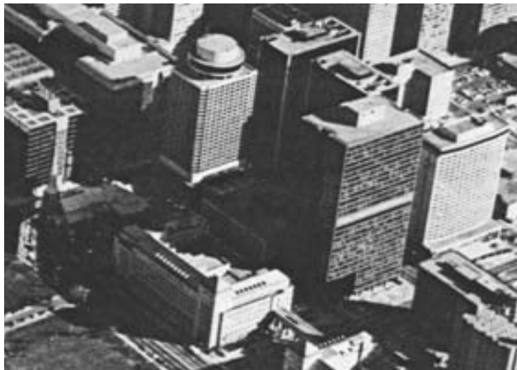
Figure 10. - Vue aérienne de la Place de Ville (Ottawa Views, 1993).
