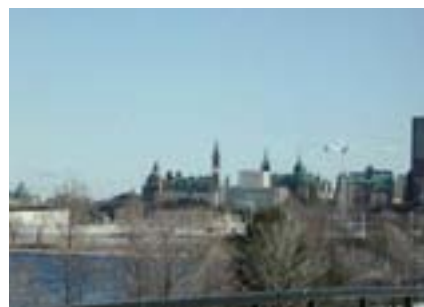
Figure 53. – Vue à partir du point d'observation n° 16 (promenade de l'Outaouais).
