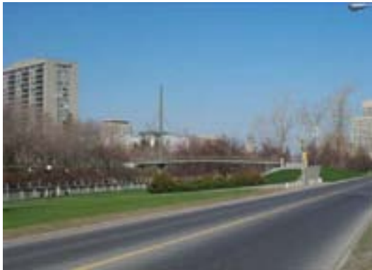
Figure 137. – Passerelle à haubans surélevée.
