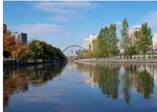
Figure 140. – Passerelle à arc simple surélevée.
