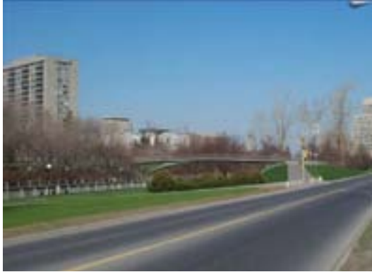
Figure 135. – Passerelle à structure rigide (à appui simple).
