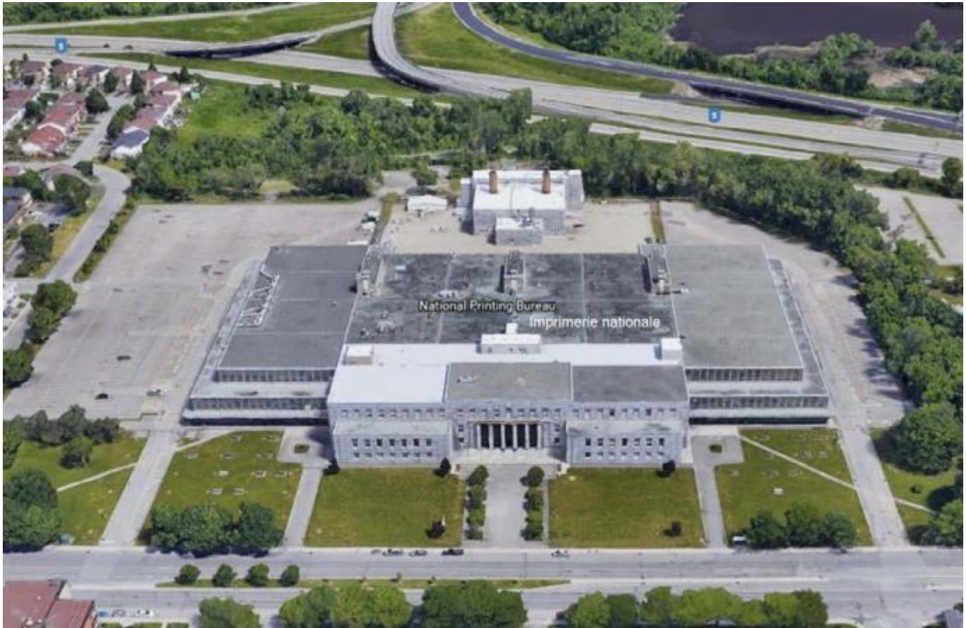
Aerial view of existing National Printing Bureau | Vue aérienne actuelle de l'imprimerie nationale
