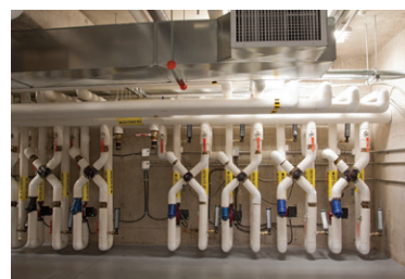
2 800 autres actifs divers (systèmes électriques, mécaniques, hydrauliques et de drainage)
