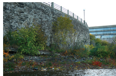
Plus de 600 structures différentes (murs de soutènement, plateformes de belvédère, barrages)
