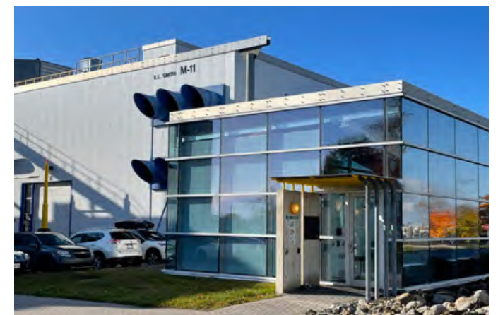
FIGURE 63. BÂTIMENT M-11 Source : Stantec
