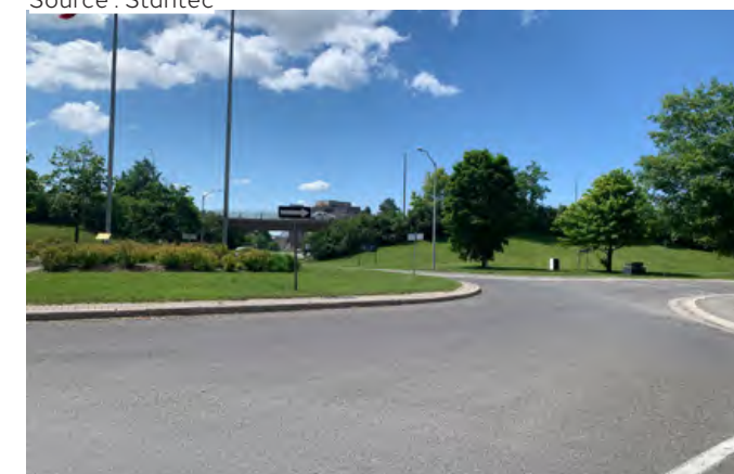
FIGURE 42. REPÈRE VISUEL SIGNIFICATIF DU VIADUC Source : Stantec
