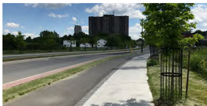
FIGURE 23. TROTTOIR ET PISTE CYCLABLE DE LA RUE WANAKI Source : Stantec
