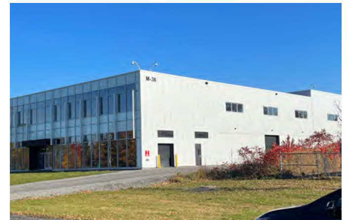
FIGURE 62. BÂTIMENT M-38 Source : Stantec
