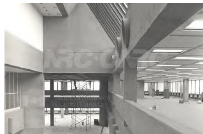
FIGURE 161. ESPACE INTÉRIEUR DU M-55 Source: NRC digital depository
