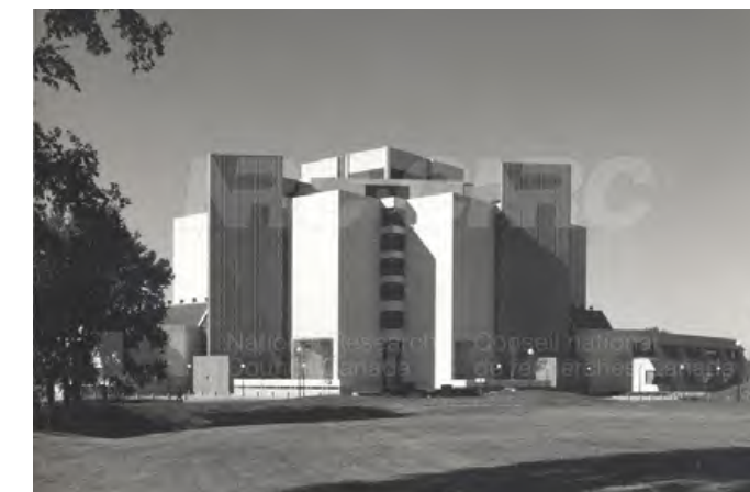
FIGURE 157. VUE ARRIÈRE DE M-55 Source: NRC digital depository
