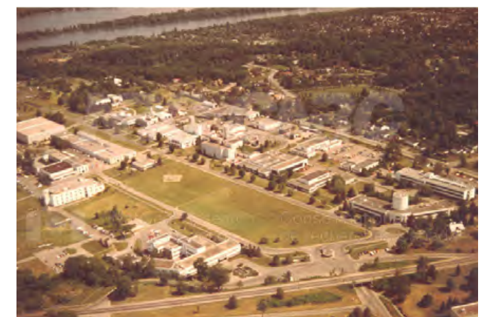
FIGURE 10. VUE AÉRIENNE DU SUD DU CAMPUS, 1968 Source : NRC digital depository
